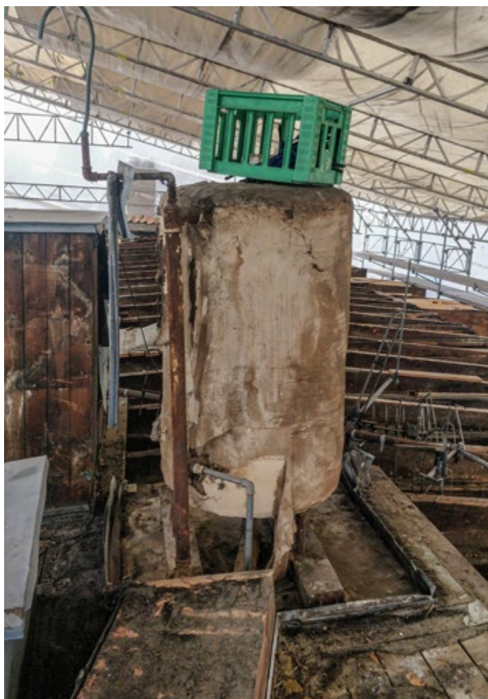
En gammel ekspansionsbeholder i kiselgur fik asbestalarmen til at ringe hos et tømrersjak. Og ikke uden grund, viste det sig.
