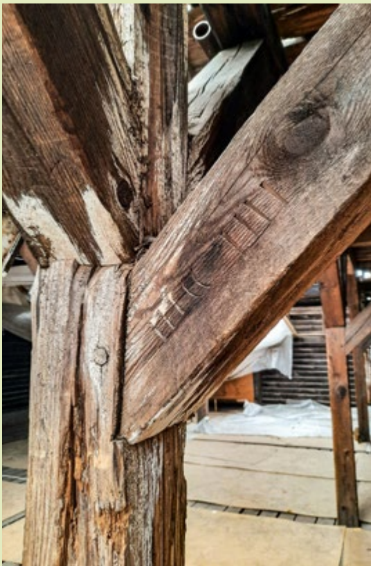
Dragere med skråstivere: I samlingerne er tapperne navlet i og skråstiverne er nummereret med romertal.
