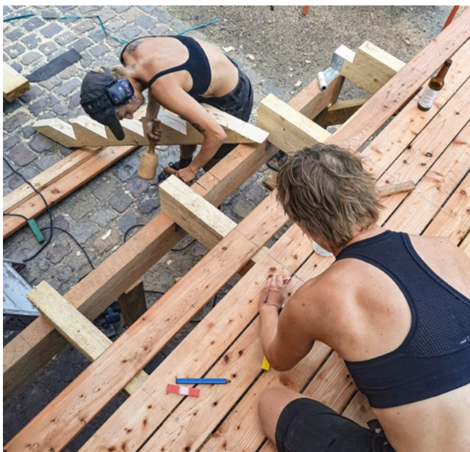
Bygningssnedker Emma Lyhn Støvring stemmer ud til trappens vanger, mens møbelsnedker Laura Klakk mærker op til skruer på terrassedækket.
