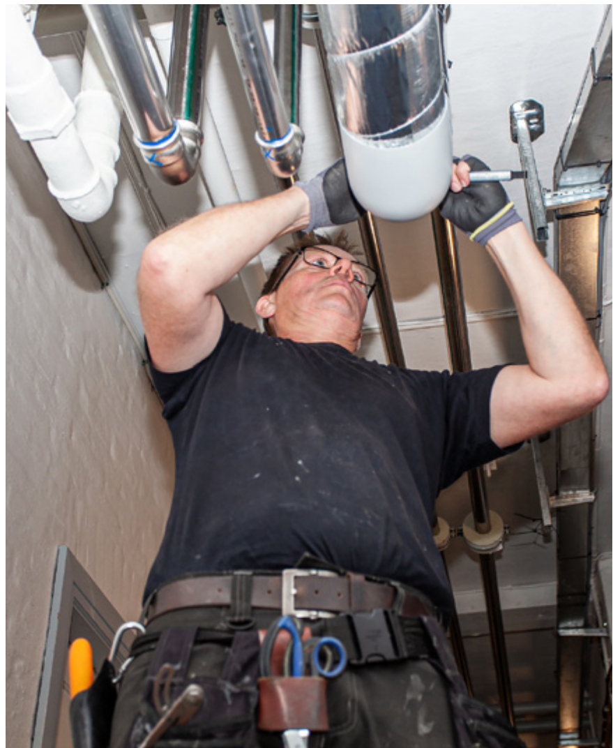
Isoleringsarbejderne var nogle af de første, der mærkede hvor farligt asbest er, og havde mange dødsfald og syge. Asbesten blev blandt andet brugt i isolering af ventilationskanaler og rør til vandforsyning.
