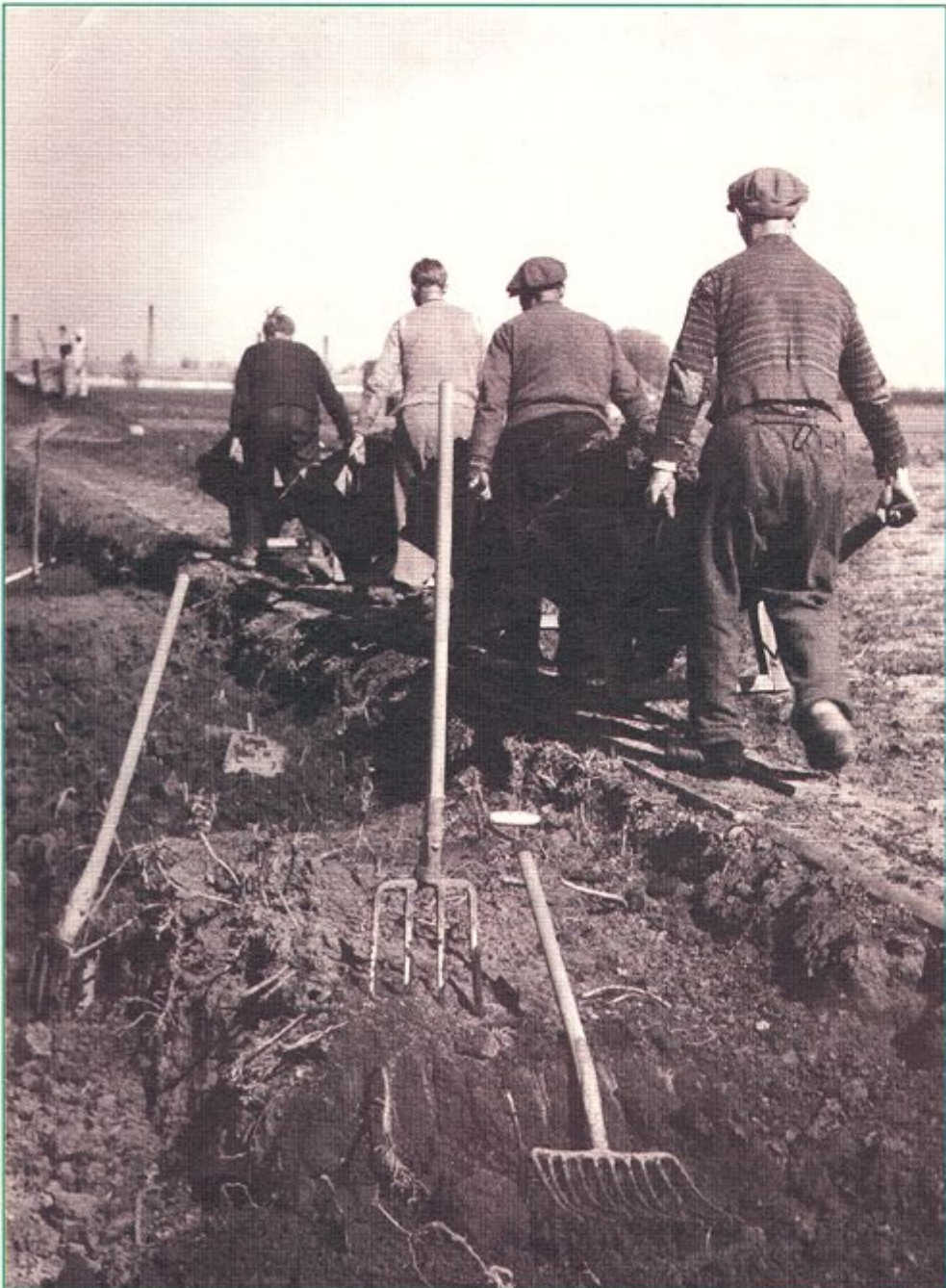
Dengang i 30'erne foregik alt jordarbejde på nødhjælpsarbejderne med greb, skovl og trillebør. Der skulle mange mand til at gøre det, en gravemaskine i dag ordner i et ruf. Men det skabte beskæftigelse....
