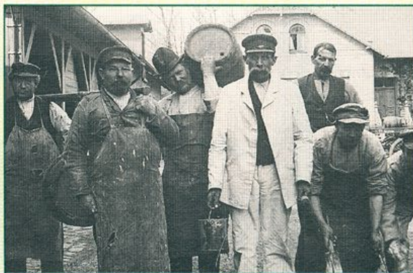
Noget af mandskabet på Kastrup Bryggeri, der lavede bajersk- og hvidtøl. Ca. år 1900
