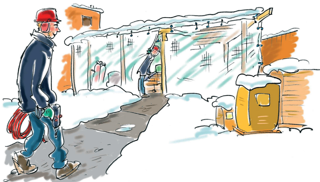
Stationær arbejdsplads opbygget med armeret plast
