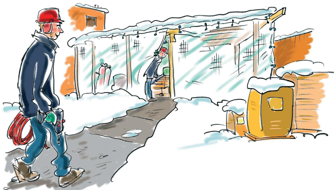
Stationær arbejdsplads opbygget med armeret plast
