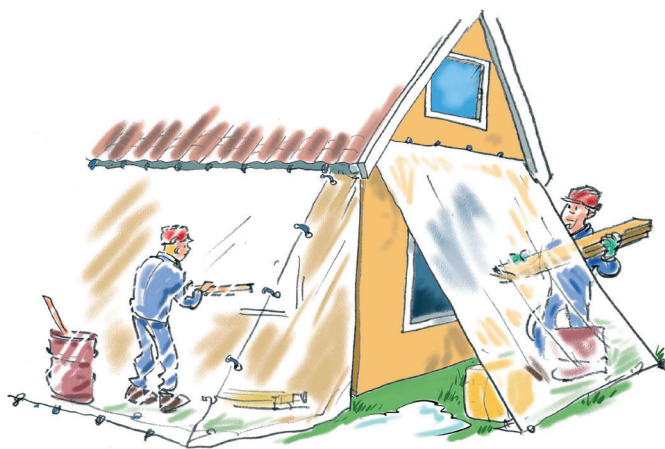
Afdækning ved facadearbejder på et et-planshus
