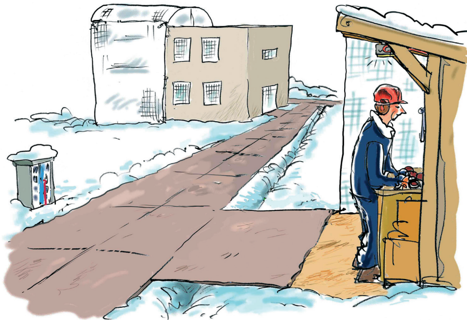
Arbejdsplads, der bruges som bukkeplads
