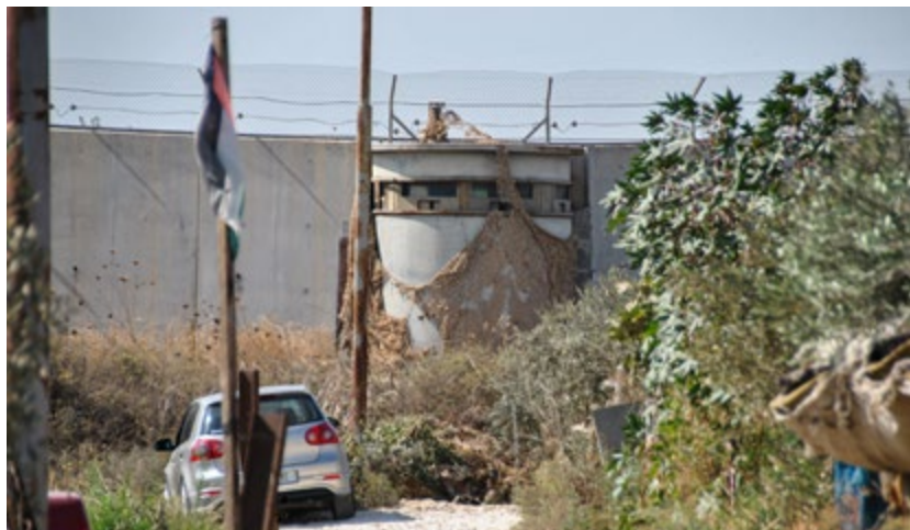
Muren ved Bethlehem med skydetårn.
