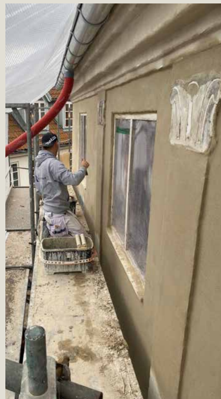
Facaden krævede mange bearbejdnings, før murerne kunne kalde den færdigkalket.
