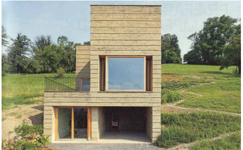
Hus af ler fra yderst til inderst bygget af den østrigske arkitekt Martin Rauch. Foto fra bogen Lerjord.
