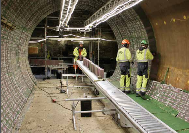
Transportbånd minimerer behovet for at løfte på de tunge ovnsten.
