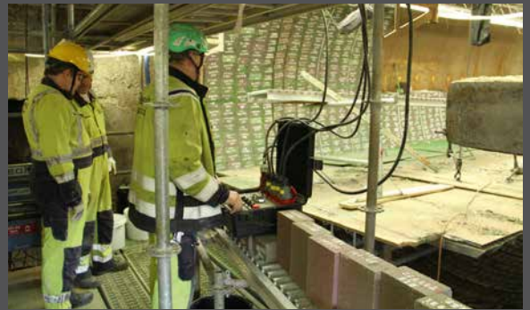
En indbygget platform gør, at arbejds højden hele tiden er tilpas. Når højden skal justeres, løftes platformen og rotérovnen drejes.
