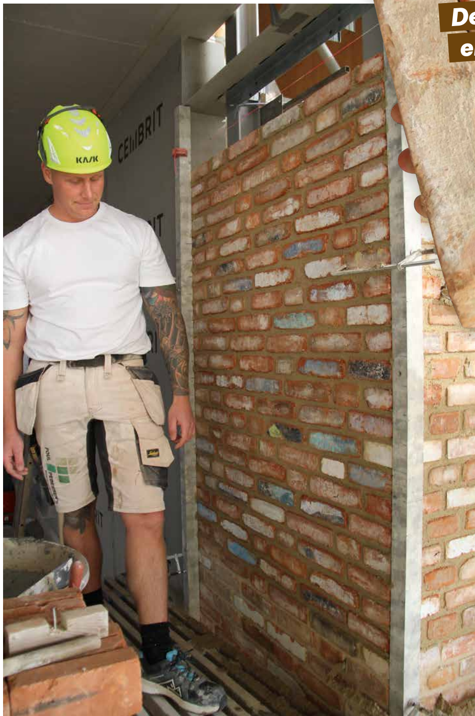
Der kommer et flot spil i murværket med genbrugsstenene, synes murer Kenni Mejdal.
