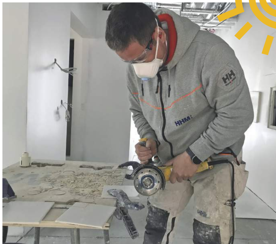
Nicki skal til at tilskære en flise. Der er både skærm og sidehåndtag på vinkelsliberen, og en gripe tang muliggør at fastholde flisen på sugebordet, så der kan arbejdes med begge hænder på vinkelsliberen.
