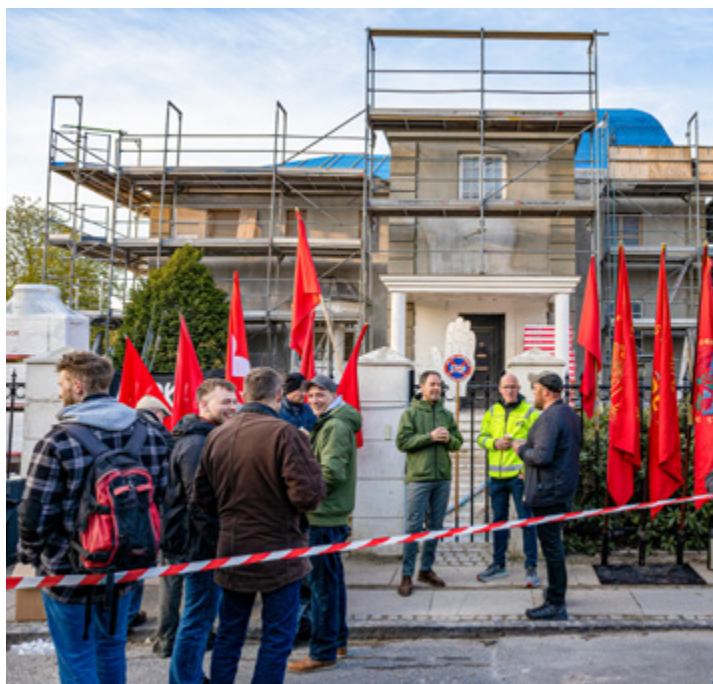
1. maj aktion på Lemchesvej 14, Hellerup, hvor JMC Construction har hyret underbetalte polske håndværkere til at istandsætte villaen.
