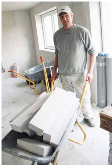
Santo Børsting på arbejde i Jyllinge, hvor Lind & Risør er ved at bygge 71 række-kædehuse.
