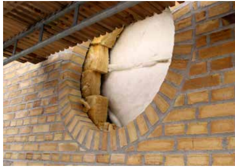
Stik over alle vinduer.
