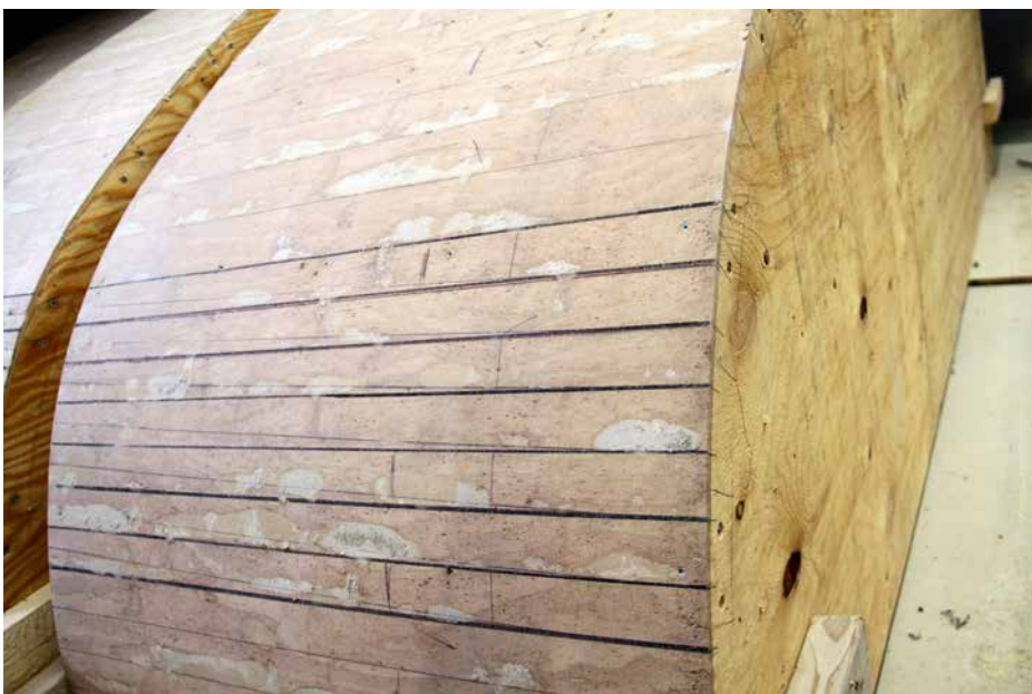
Forskallingerne til de store buer.
